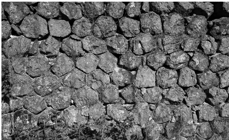
Mur en appareil d'orgues basaltiques. Ancienne dépendance utilisée pour les ovins
