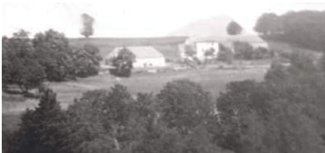
À gauche, le Petit Bleynet ; au centre, l'ancienne Tour du Bleynet, maison de maître et en arrière-plan, le Grand Bleynet (cliché de 1890)
